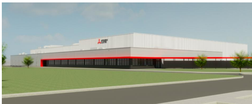
Bilde av det nye anlegget ved MEAC
