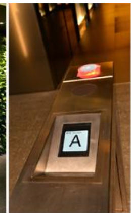
Brukerens tildelte heis vises på sikkerhetsportens LCD-indikator
