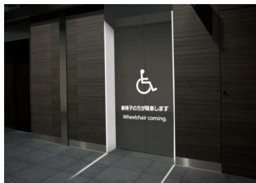
Veiledning projisert på heisdøren
