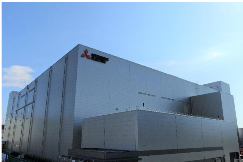
Nytt anlegg ved Kamakura-verket
