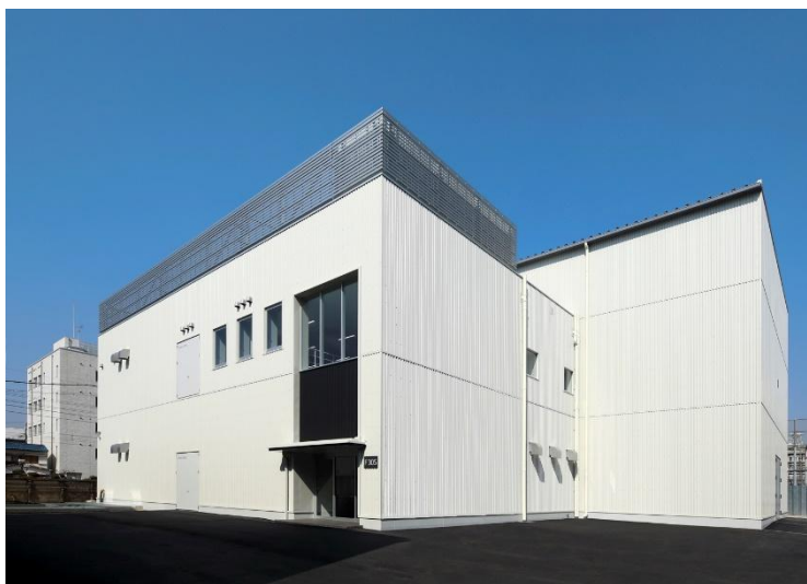
Mitsubishi Electrics nye HVDC-verifiseringsanlegg
